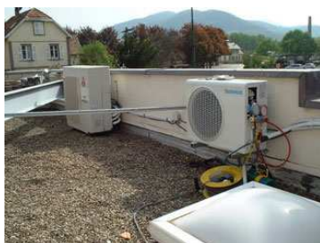
Sur le toit derrière un mur acrotère
