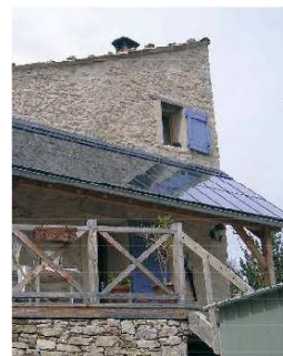
En couverture d'une pergola
