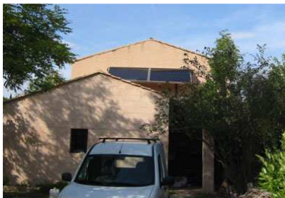
En garde corps au-dessus d'un pan de toit
